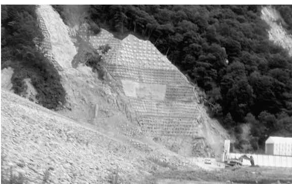
6.14 堤体付近から崩落した胆沢ダム
