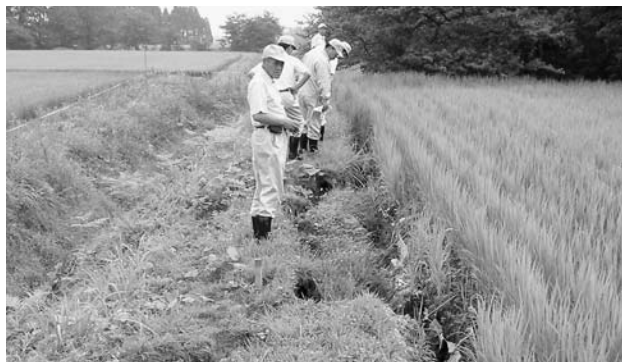
亀裂の入った水田（胆沢区）
