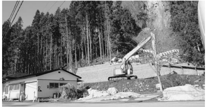
避難地区の災害関連緊急治山工事（衣川区土土地内）
