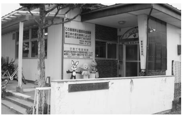
市立いずみ保育園（水沢区）
