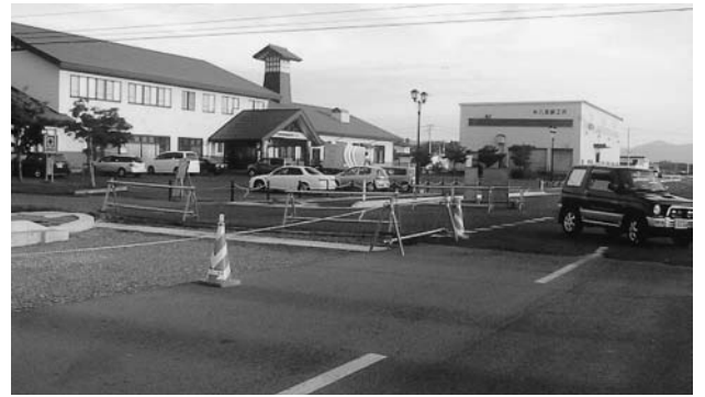
産業観光鋳物工場街一関～北上線 (完成22年度)
