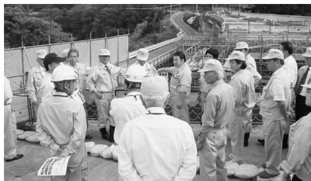
復旧状況現地調査（衣川区）
