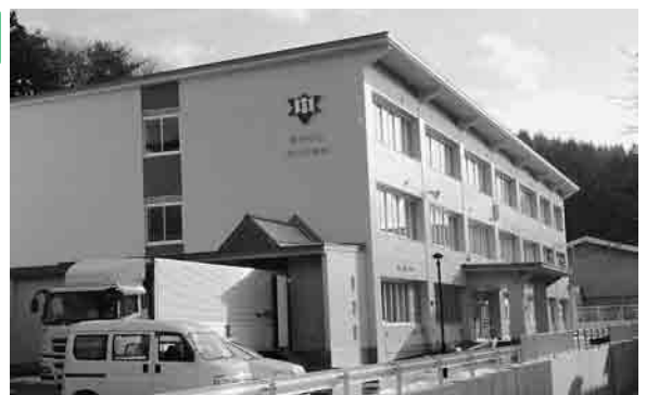
内装材に地元産木材を活用した衣川中学校校舎
