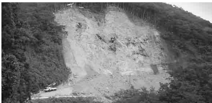
土砂崩落現場の復旧状況（衣川区）
