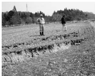
水田の亀裂（江刺区内）
