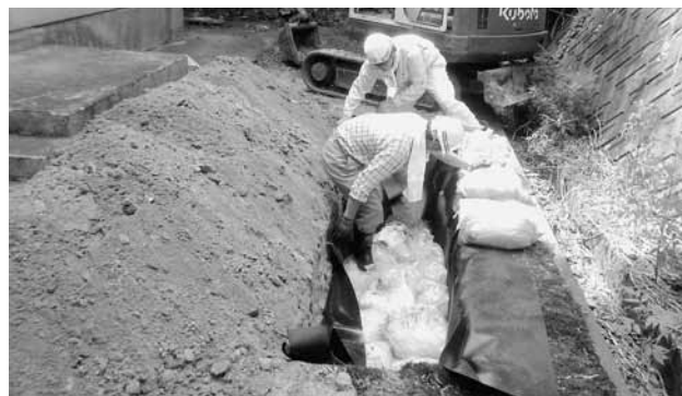
汚染土壌を遮水シートに包み埋設（白鳥小学校〈前沢区〉）
