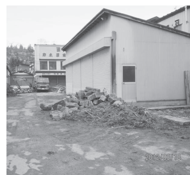
市の解体作業が始まった前沢区三日町
