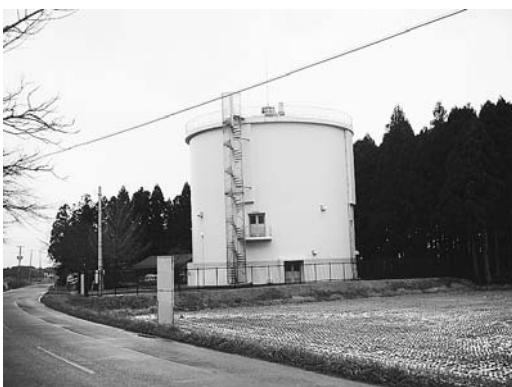
日除松配水塔（前沢区）
