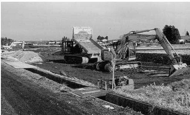
高生産性農業の展開に向け整備する 県営圃場整備事業(胆沢区南部田地区)
