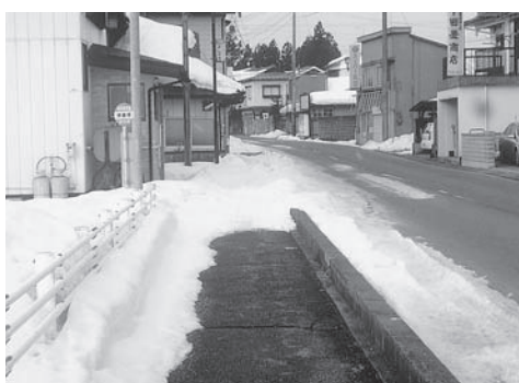
除雪により堆雪された歩道
