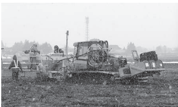
南都田地内の暗渠工事
