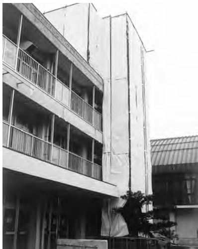
大規模改修工事中の水沢南中学校
