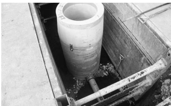
公共下水道工事
