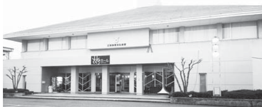
改修が急がれるささらホール
