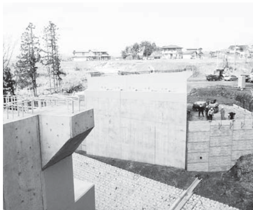
工事が進む市道北鵜ノ木西田線
