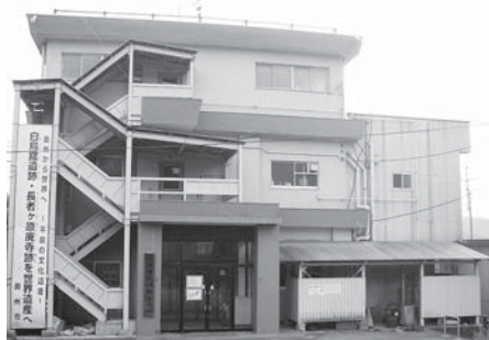
解体予定の旧衣川支庁舎
