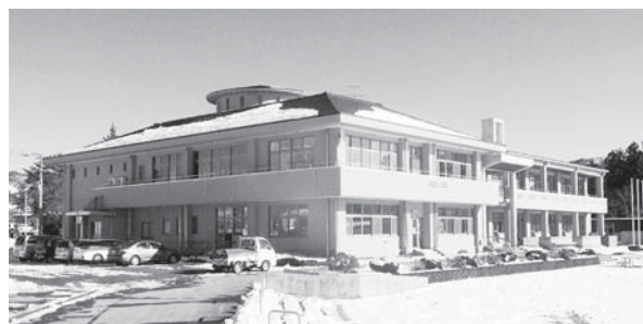
平成14年度から供用が開始された梁川小学校
