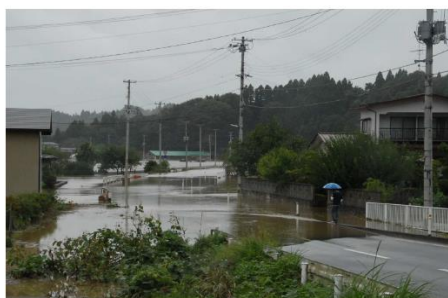
【北上川増水のため冠水した景観(奥州市水沢黒石地区:平成19年9月18日撮影)】
