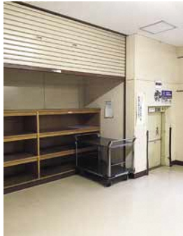
給食受配用に修繕される配膳室
