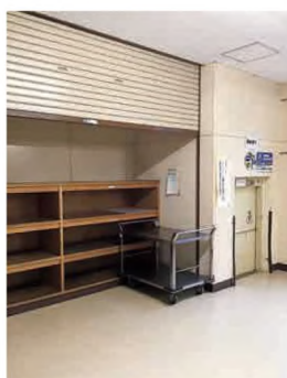
給食受配用に修繕される配膳室
