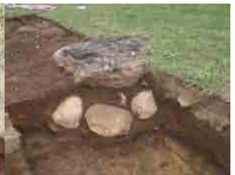
写真39 礎石の設置状況③
