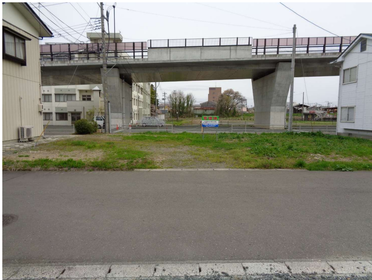
(敷地の北側市道から撮影)
