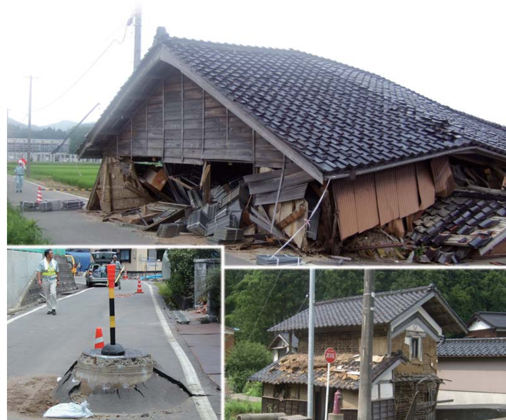
新潟県中越沖地震の被害状況（災害復旧支援に派遣された本市職員撮影）
